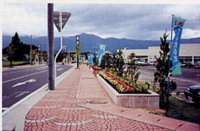
花の回廊整備工事 白鷹町荒砥地内
