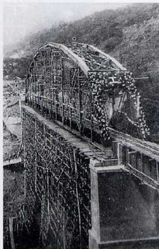
完成間際の橋梁
