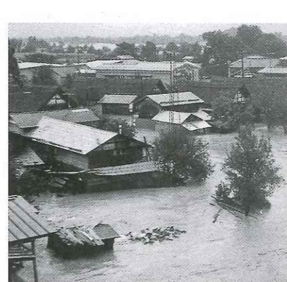
1967年の羽越水害の様子(川西市)
